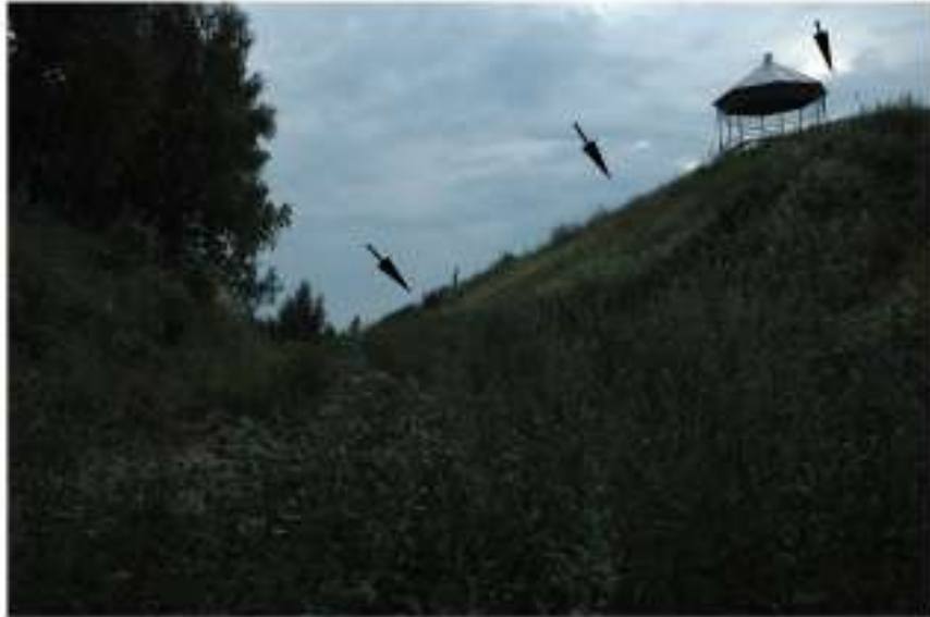
Рис. 11. Наружный (юго-восточный) откос юго-восточного вала (указан стрелками) и ров между ним и северо-западной границей Верхнего городища. Вид с северо-востока.
